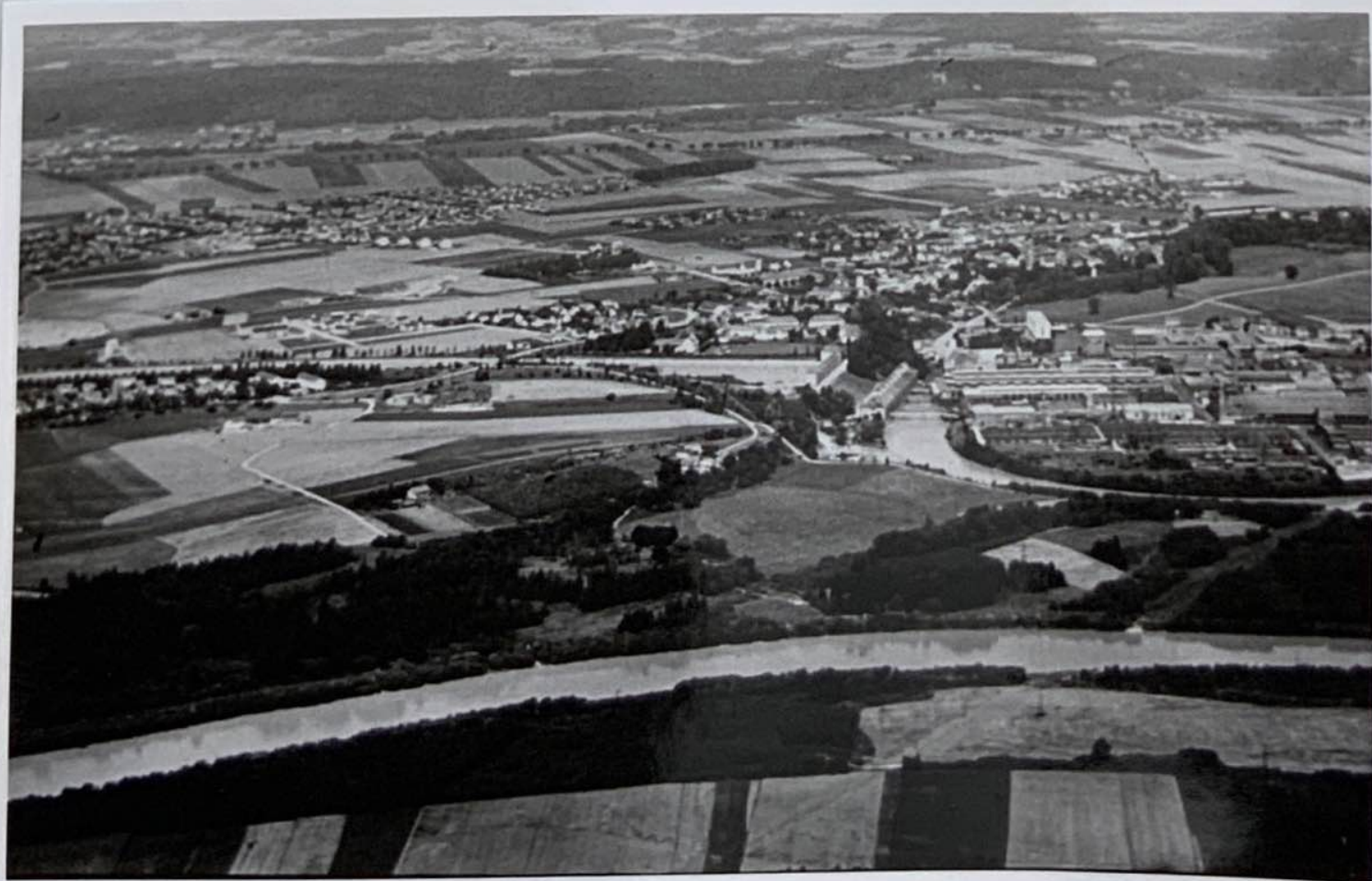
Die Industrieanlagen und der Ort Töging
