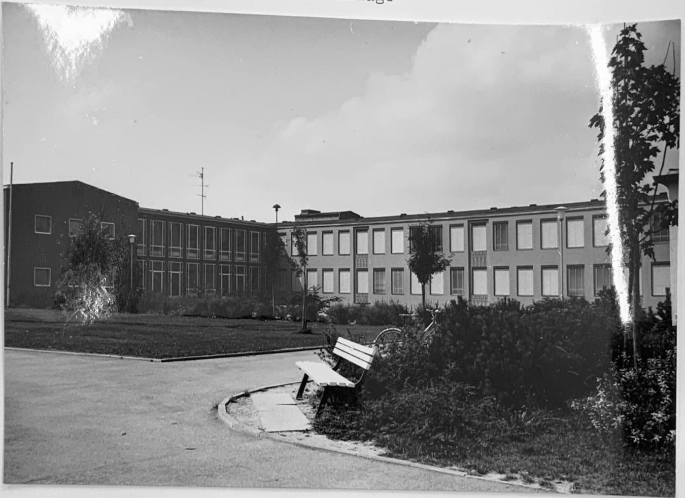
Die fertig gestellte Schulanlage
